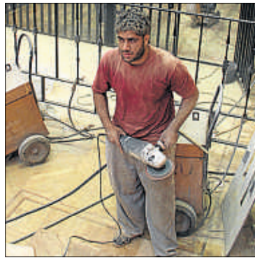
Un obrero de la construcción
